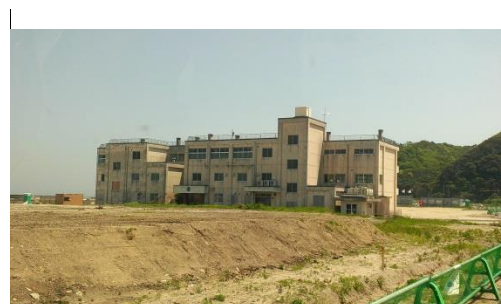
*海岸に面している旧豊間中学校校舎
