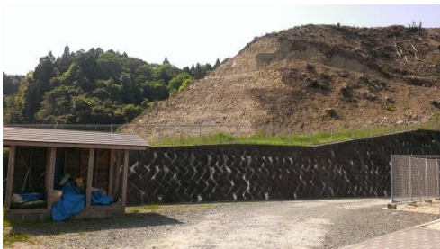
*豊間小学校の裏山を削って再造成中。 海拔も高く安全なこの場所に豊間中学校の新校舎が 作られる計画です
